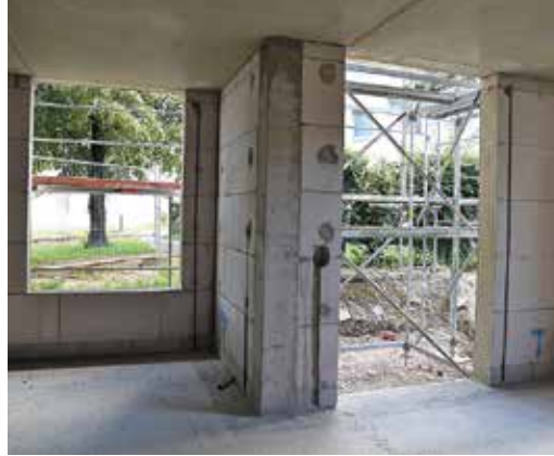
Der Rohbau lässt es bereits erahnen – die Räume werden lichtdurchflutet sein.
