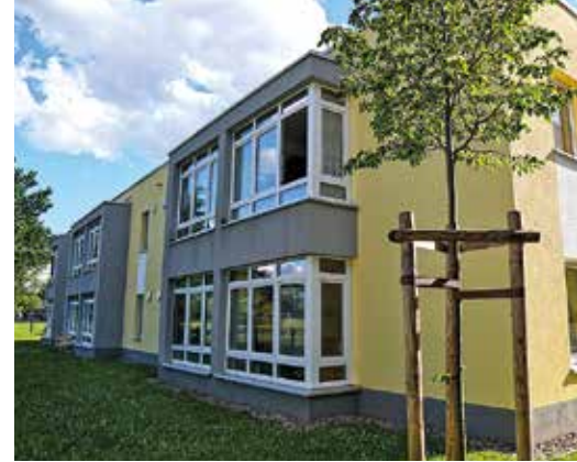
Das erste Haus mit 10 Wohnungen, errichtet vor fünf Jahren
