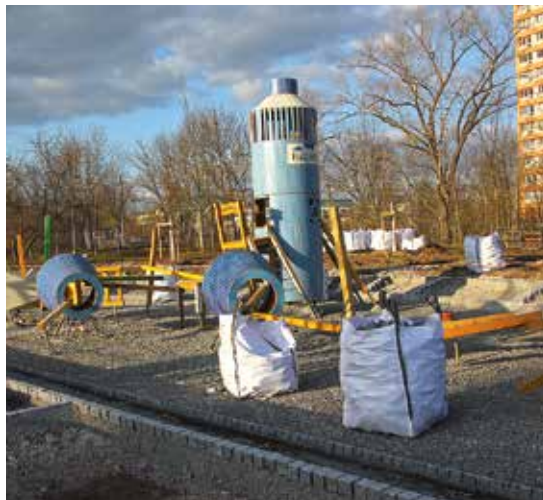
Fläche für den künftigen Bolzplatz ist vorbereitet
